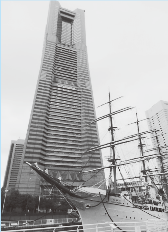
横浜みなとみらい地区のランドマークタワーと帆船日本丸
